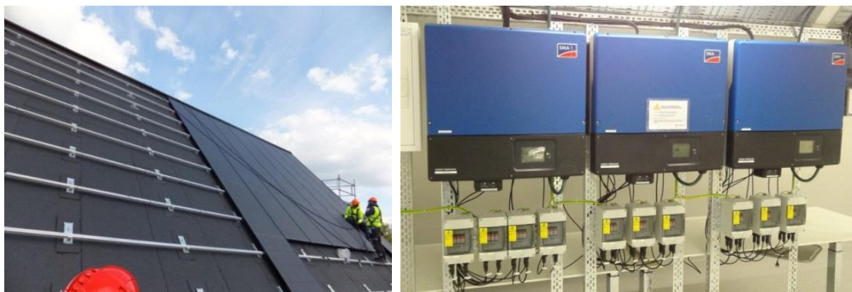
Figur 16 Montage av solcellsmodulerna på norra huskroppen, Maj 2012, samt växelriktarna i fläktrummet.
