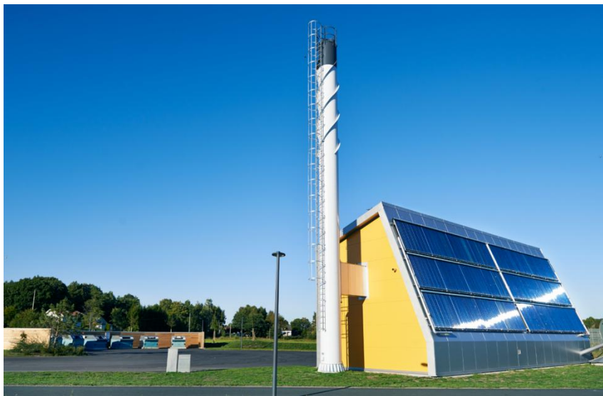
Figur 4 Panncentral med solfångare Vallda Heberg, Kungsbacka
