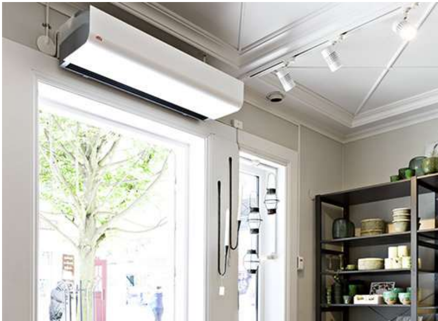
Figur 1. Luftridå monterad ovanför dörröppning (Frico, 2019)
