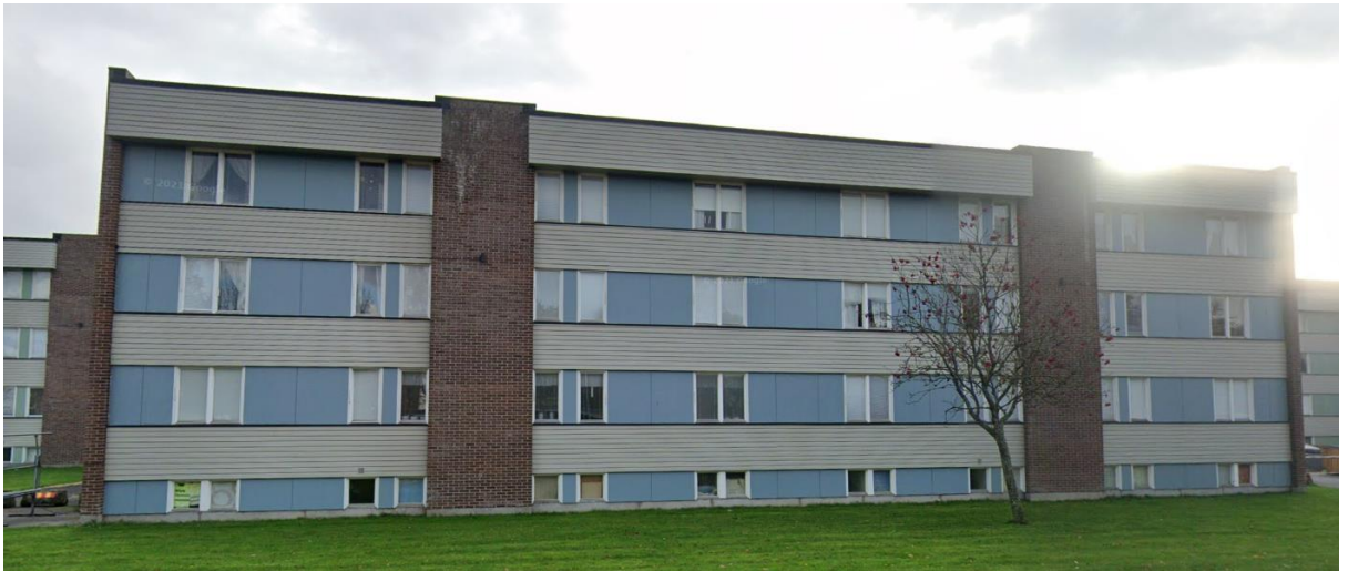
Figur 6. Ågårdsvägen 50-52. Källa: Google maps.
