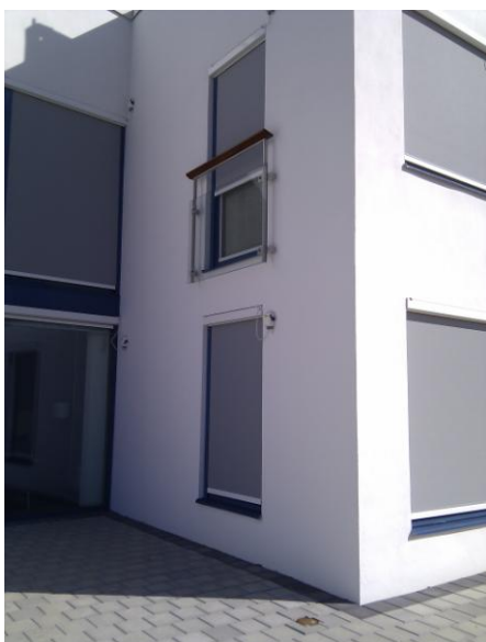
Figur 3 Solavskärmning med utvändiga markiser (okänsliga för vind). Markiserna ger ett visst dagsljus inuti byggnaden.
