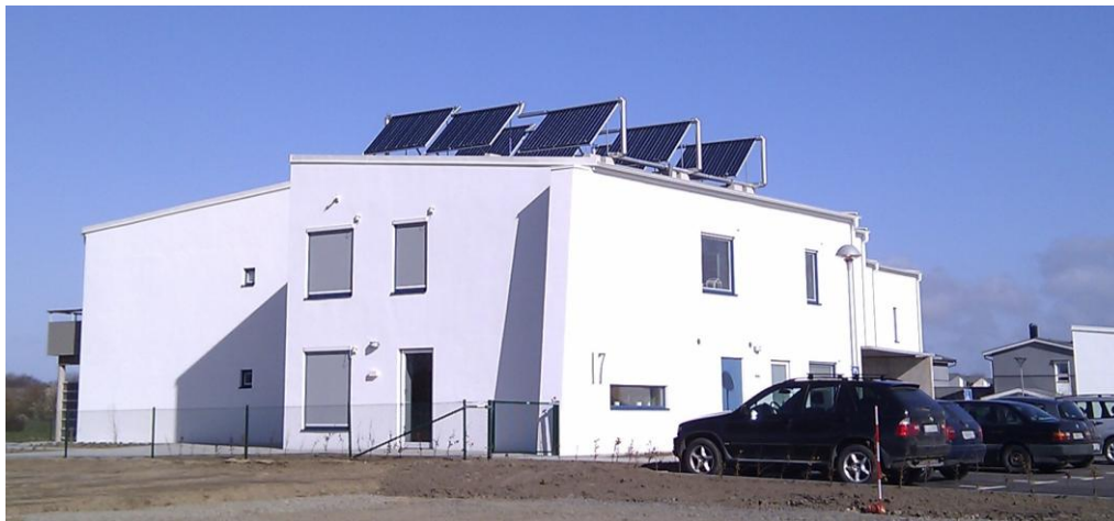
Figur 2 Solanläggning av typen vakuumrör är placerade i söderläge på taket.
