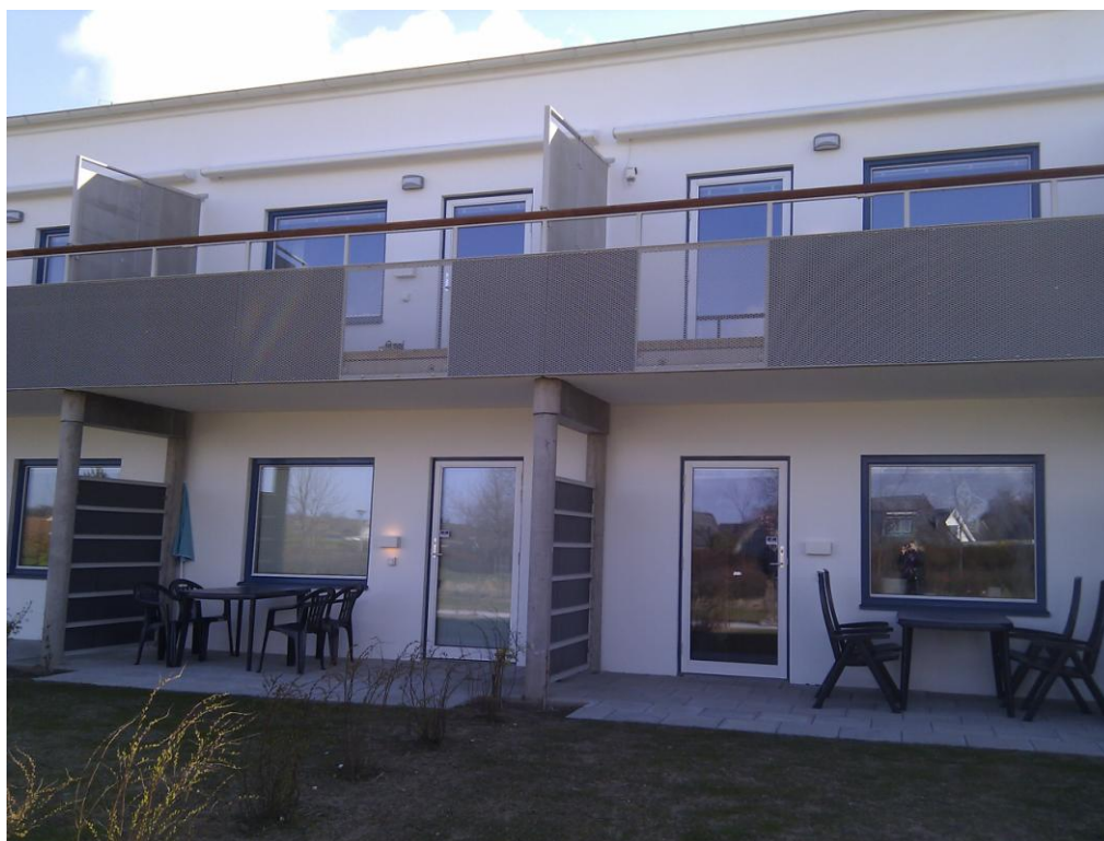
Figur 1 Byggnaden har tolv lägenheter.
