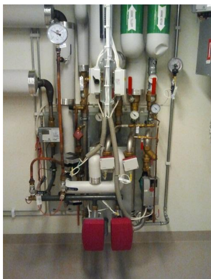
Bild 3 Fjärrvärme växlare
