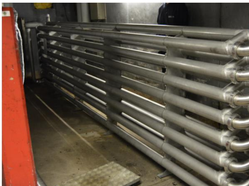
Figur 3 – Den aktuella värmväxlaren på BRF Promenaden [9]
