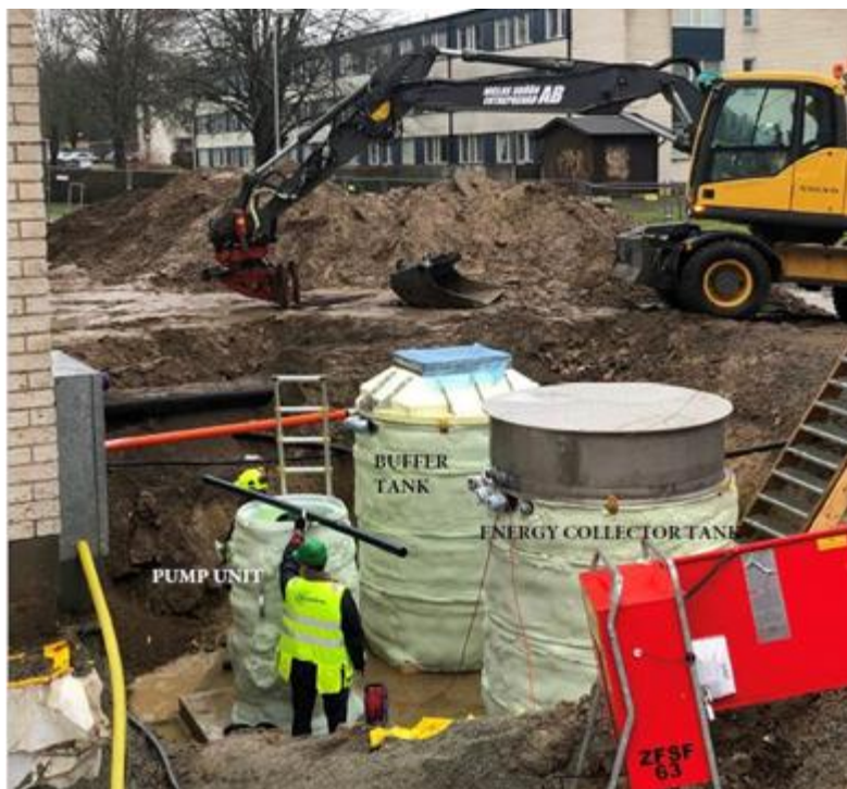
Figur 8 – Bild från Växjöbostäder på bufferttank, kolektortank och pumpgrop vid installationen
