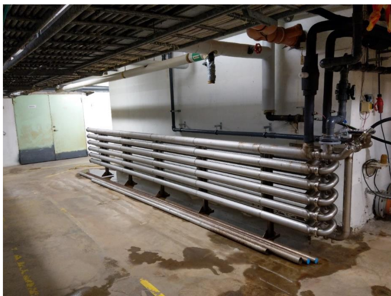
Figur 15 – En av de två aktuella värmeväxlarna på Gustavsviksbadet
