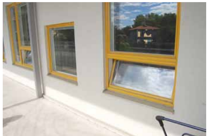
Fönster i barnens nivå ger kontakt mellan ute och inne.
