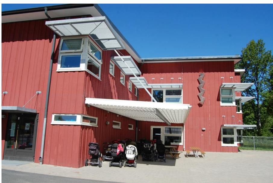
Blackevägens förskola. Fasta solskydd över fönster och uteplats.
