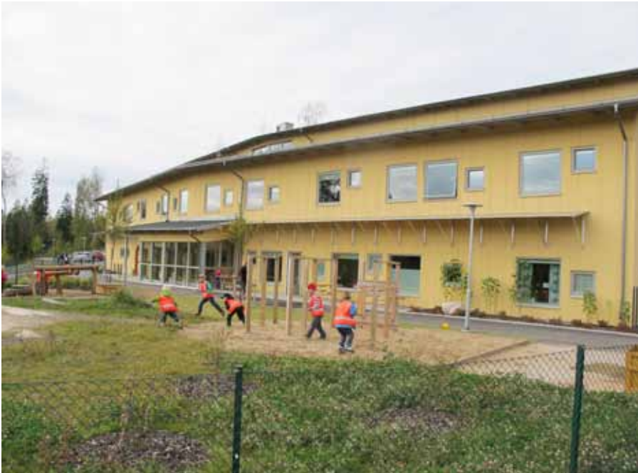
Söderfasad. Solceller på skärmtak.
