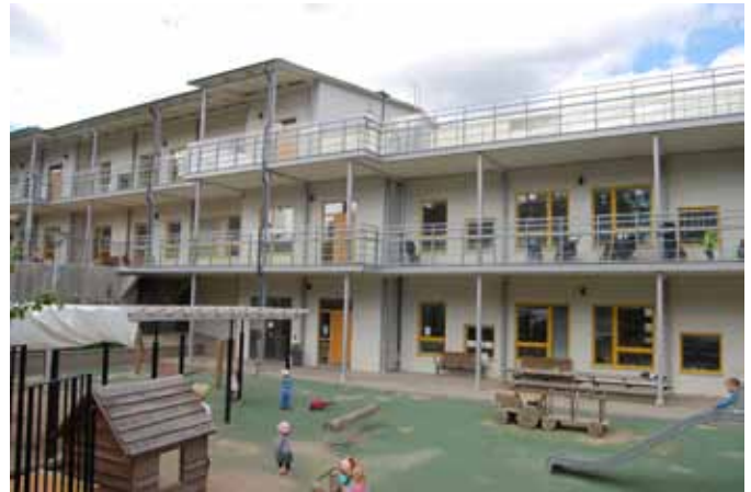
Varje avdelning har egen entré via loftgångarna på gårdssidan.
