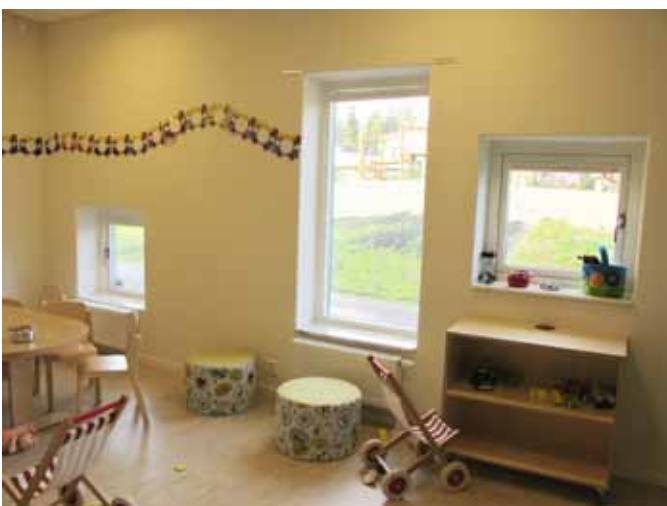
Radiatorer försvårar användning av fönsternischen.
