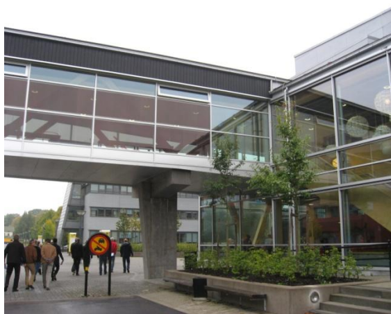
Solceller i glas på gångbro mellan byggnaderna.
