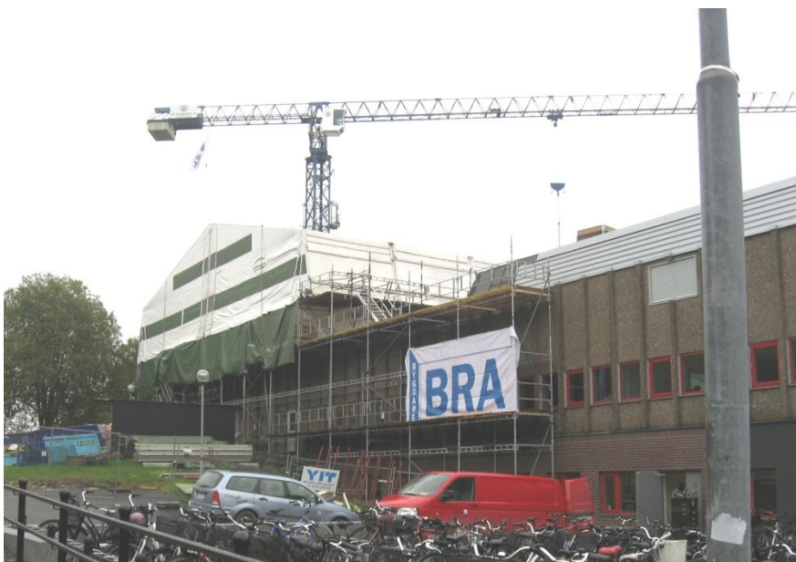
Byggnation sker under vädskydd.
