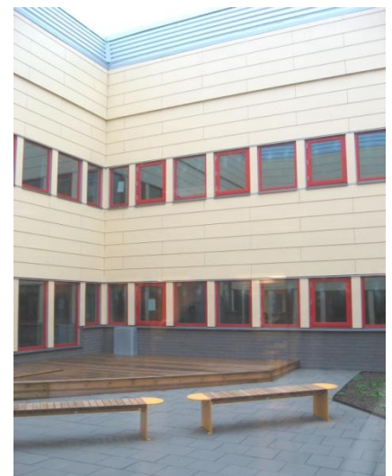
Innegård som renoverats. Här syns hur taket höjts för att ventilationskanaler ska få plats.
