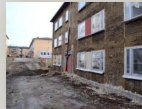
Alingsås (S) Frame structure
